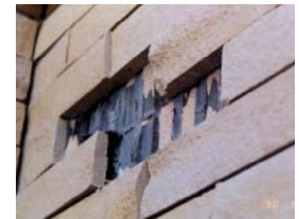
〈A〉突き付け目地施工による剥離事例
